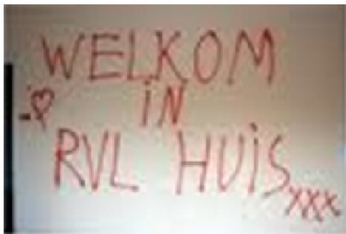
Een voorbeeld van RVL vandalisme
